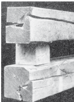
Bild 4: Veröffentlichung von Otto Graf in Heft 26 der Mitteilungen des FA für Holzfragen zu Untersuchungen der Festigkeit von Vollholz mit starker Rissbildung (aus [40])
